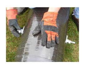
FIGURE 9 LIGHT DUTY POLE SECURING JOINT ()
